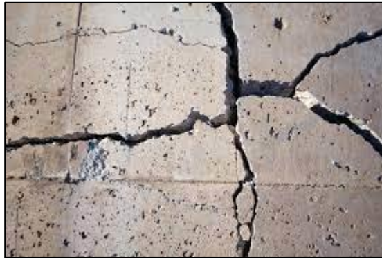
Figura 5. Imágenes de problemas de fraguado de hormigón. 38
